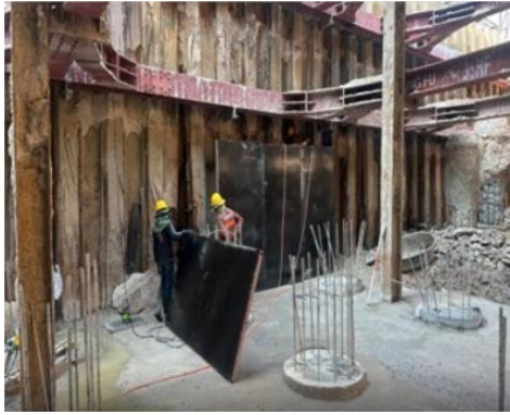
รูปที่ 5 แนวผนังกันดินชนิดเข็มพืดเหล็ก (Sheet Pile) และค้ำยัน (Bracing)
