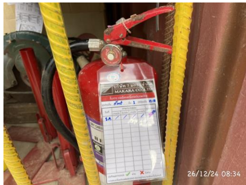
รูปที่ 45 ถังดับเพลิง และเจ้าหน้าที่ตรวจสอบสภาพพร้อมใช้งาน
