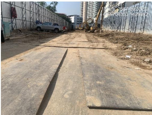
รูปที่ 10 แผ่นเหล็กสำหรับทางวิ่งรถ
