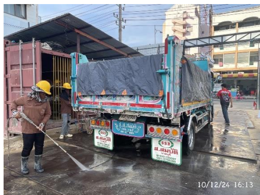
รูปที่ 8 คนงานล้างล้อรถบรรทุก
