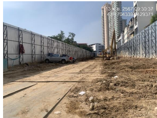
รูปที่ 1 รั้วชั่วคราว Metal Sheet ความสูง 6 เมตร
