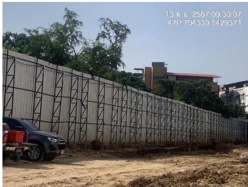
รูปที่ 1 รั้วชั่วคราว Metal Sheet ความสูง 6 เมตร
