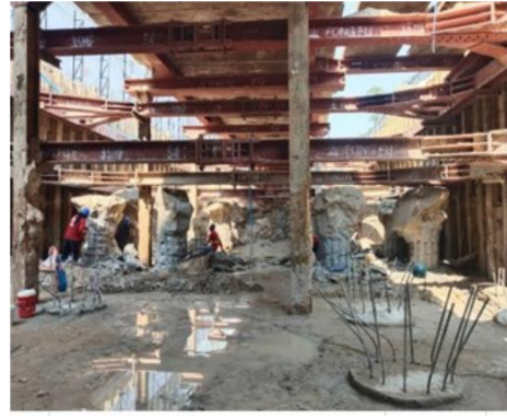
รูปที่ 5 แนวผนังกันดินชนิดเข็มพืดเหล็ก (Sheet Pile) และค้ำยัน (Bracing)
